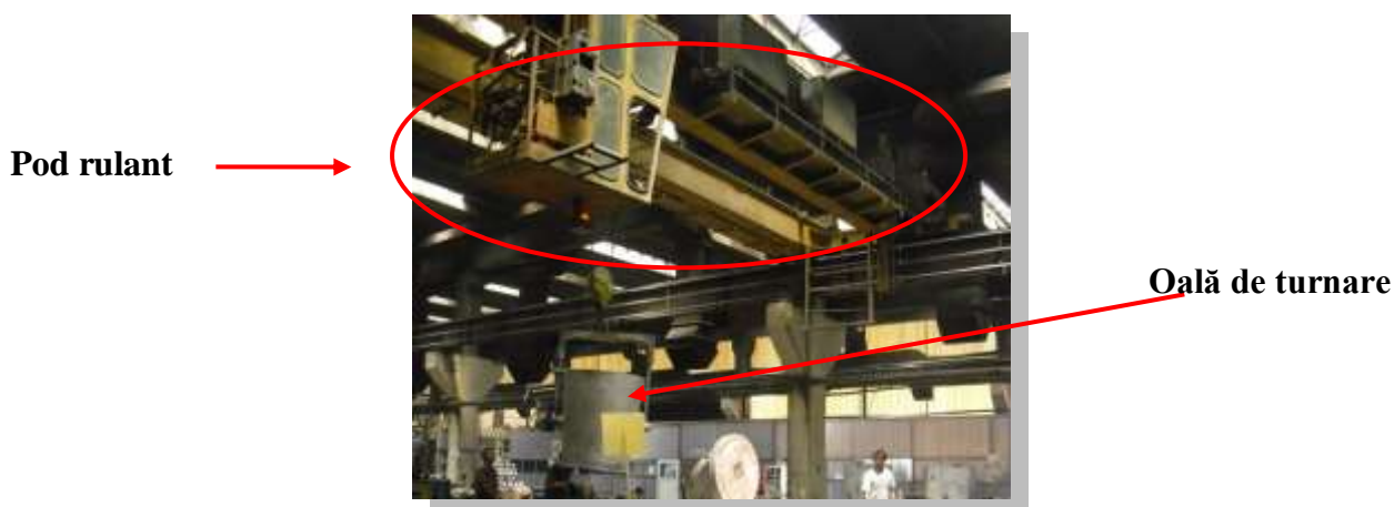
Fig. 11 - Transportul oalei de turnat de la cuptorul de topire la cuptoarele de menținere
