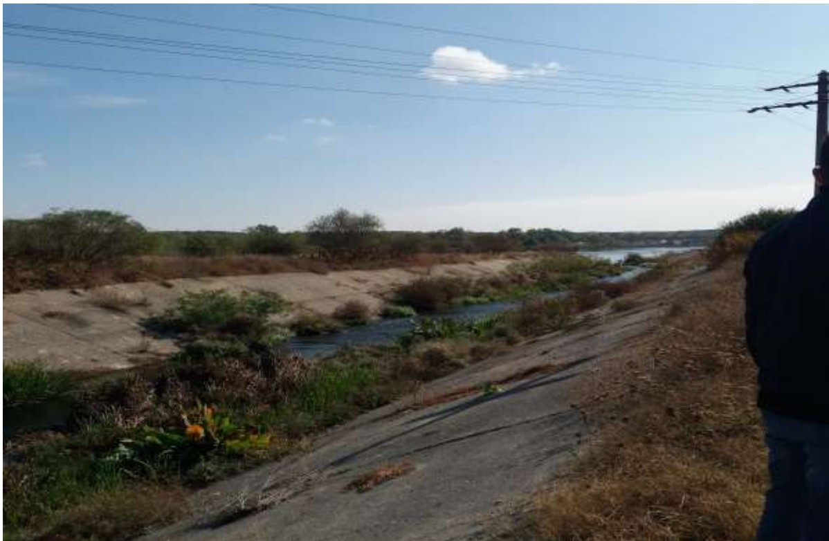
Fig. 3 – Descarcare in emisar - foto
