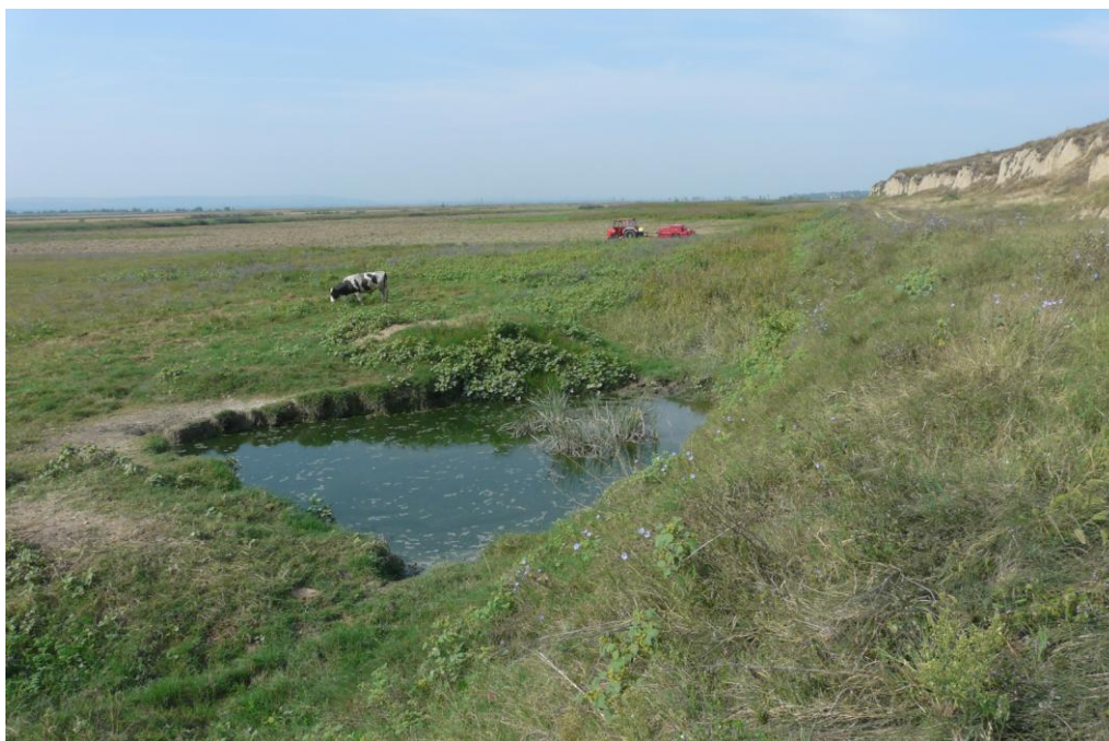
Foto – zona de baltire a apei – canal colmatat
