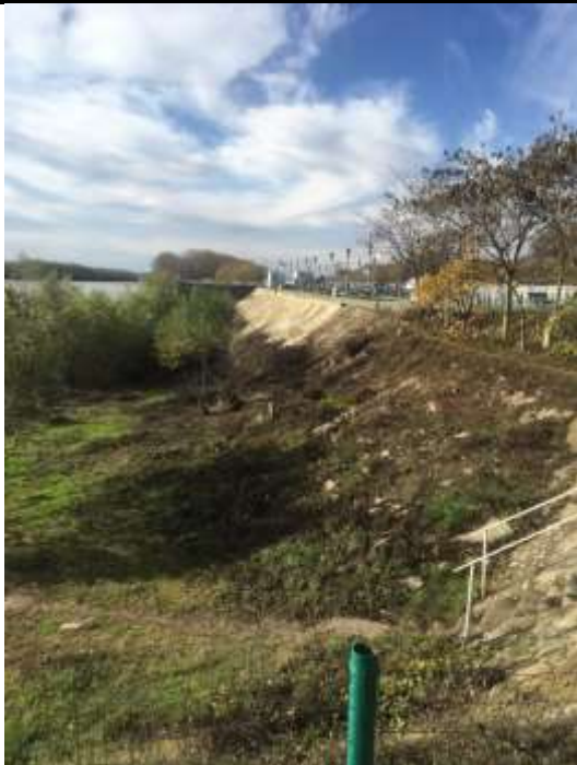
Zona lucrarilor cheu+platforma
