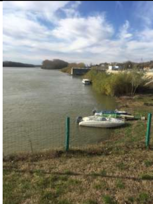
Zona lucrarilor cheu+platforma
