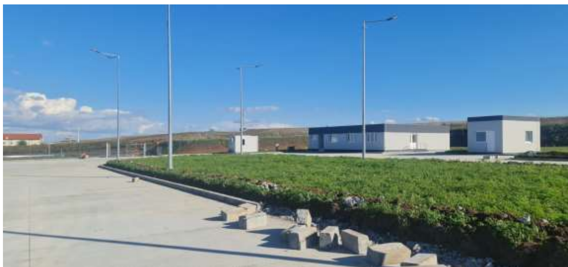
Fig. 3 – Imagine amplasament instalație preparat mixturi asfaltice
