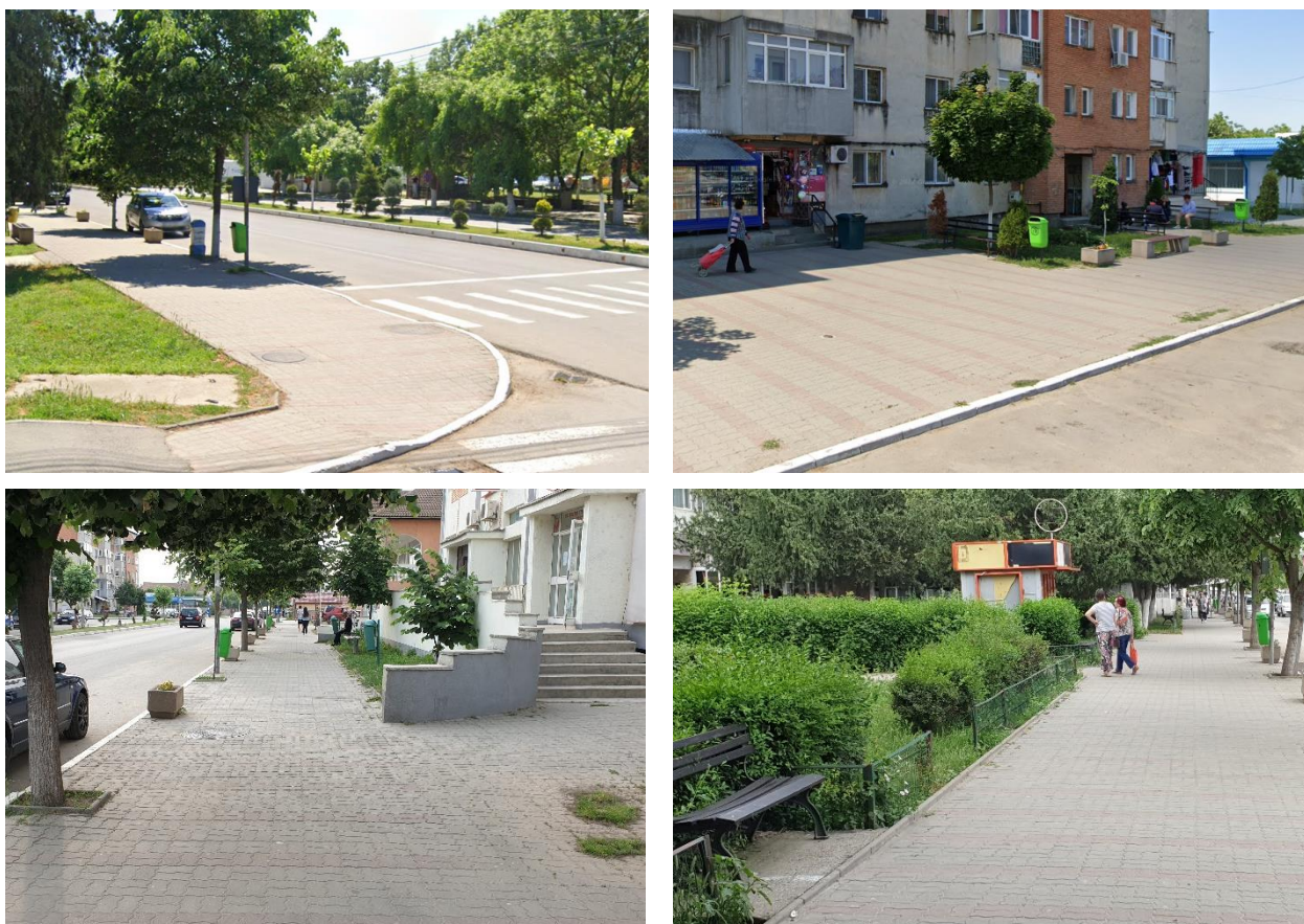
Figura 2.49. Trotuare în stare bună (exemplificare).
