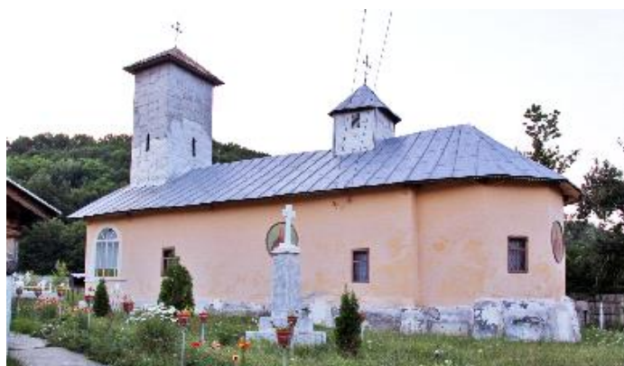
Fig. 19 Biserica de lemn "Adormirea Maicii Domnului"- situată în satul Spătaru. Datează din anul 1900.
