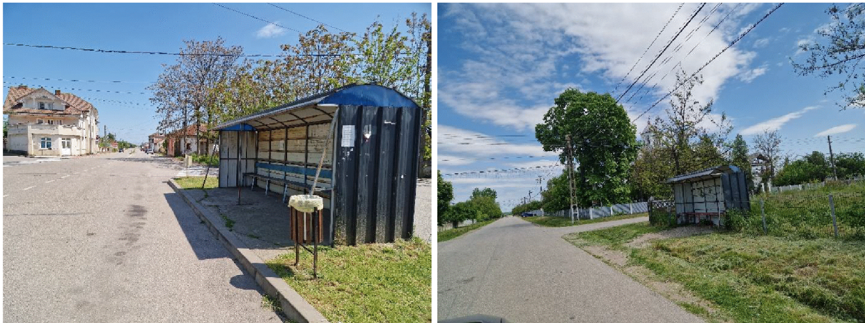
Figura 2.34. Stații de transport public amenajate.
