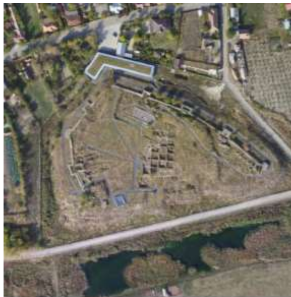
Figură 1 – Cetatea Sucidava (vedere aeriană)
