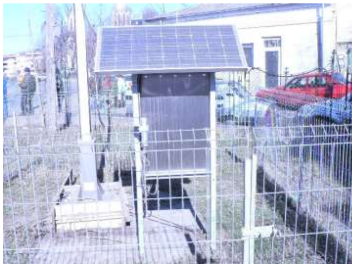
Fig. IX.1.2. – Tabloul de comandă al stației de radioactivitate – APM Olt
