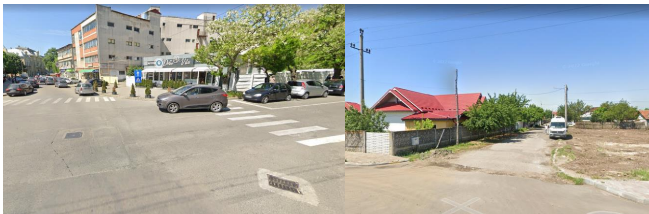
Figura 2.43. Străzi a căror suprafață de rulare se află în stare tehnică proastă/ neasfaltate (exemplificare).
