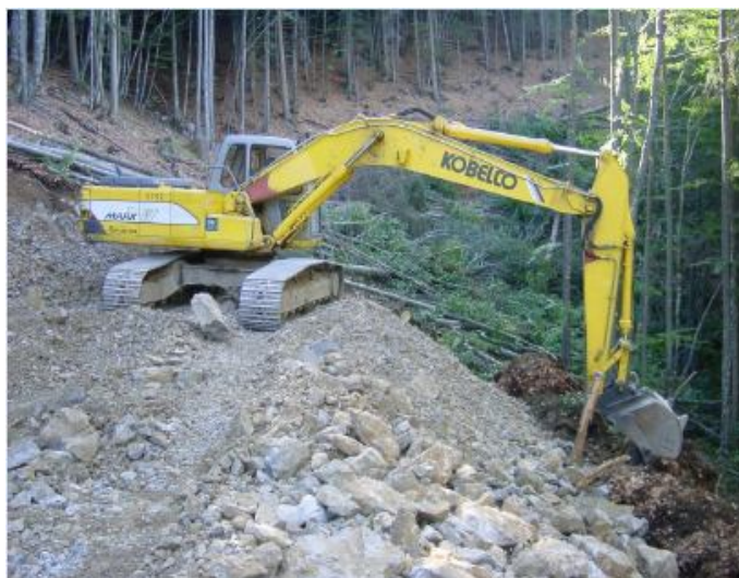
Excavator în lucru, cf. Ghidului de bune practici pentru drumuri forestiere
