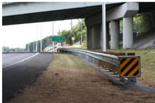
Figura 28: Dispozitive de protecție corespunzătoare (Sursă: Manual de siguranță rutieră pentru Rep. Moldova. Administrația de Stat a Drumurilor, 2011)
