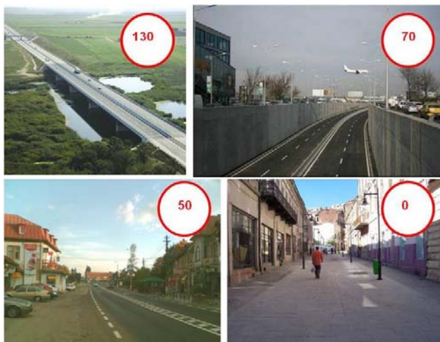
Figura 4: Exemple de drumuri lizibile (Sursă: Manual de siguranță rutieră pentru Rep. Moldova. Administrația de Stat a Drumurilor, 2011)
