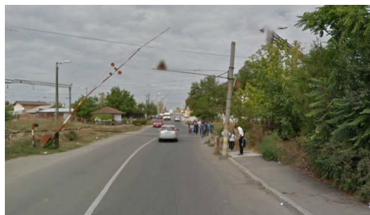
Traversare la nivel pe str. Văleni
