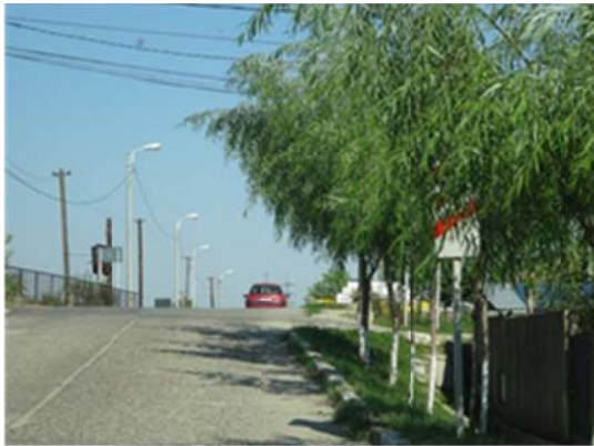
Figura 36: Exemplu de trecere la nivel cu calea ferată presemnalizată necorespunzător, Ploiești, Strada Izvoare
