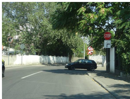
Figura 3: Exemplu de intersecție semnalizată ambiguu, Ploiești, intersecția dintre Strada Tribunei și Strada Sondelor
