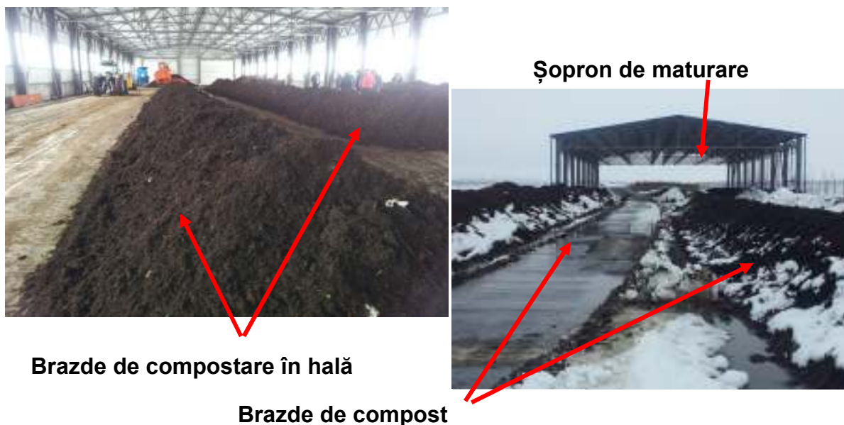
Figura 4.11. Imagini de la stația de compostare Balta Doamnei
