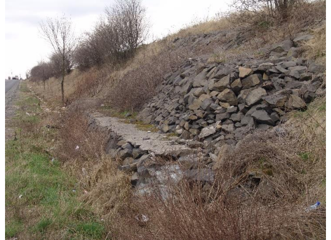
Figura 16. Utilizarea de bolovănișuri ca microhabitate este în măsură a oferi nișe suplimentare ecologice (stânga) și funcționând ca zone de drenaj a apelor de spălare ce contribuie substanțial la stabilizarea pantelor (dreapta)
