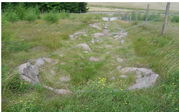
Figura 8. Model de rigolă înierbată și întărită cu piatră naturală ce asigură scurgerea apelor pluviale într-o manieră ce replică structuri naturale
