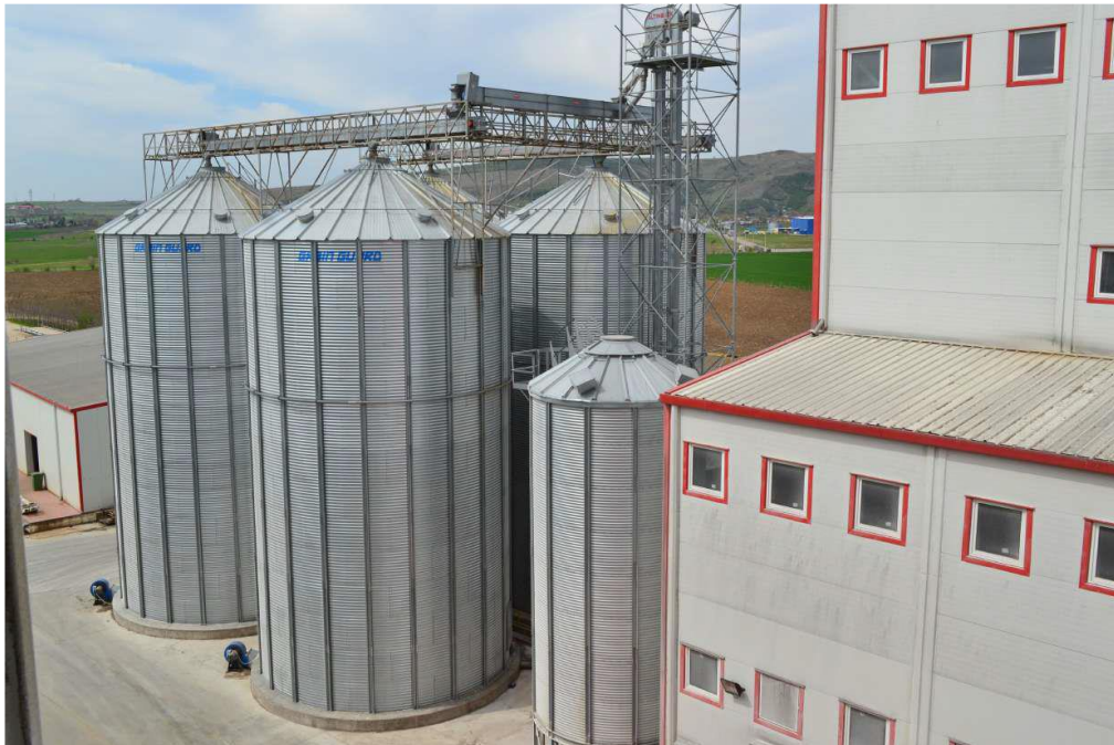
Figura 6: Silozuri de stocare
