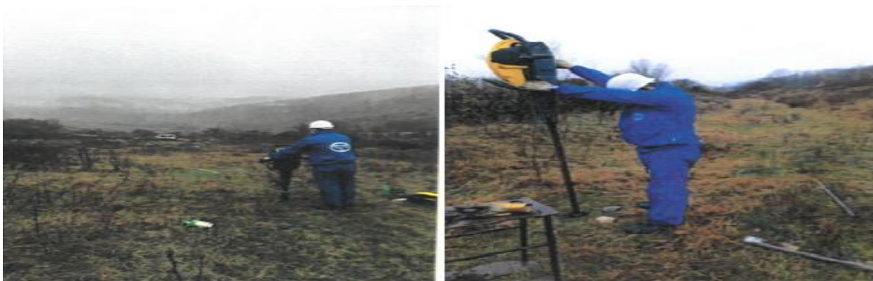
Imagini din cadrul forajelor geotehnice executate
