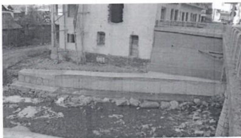
Consolidare de mal din 2011 aval dreapta
