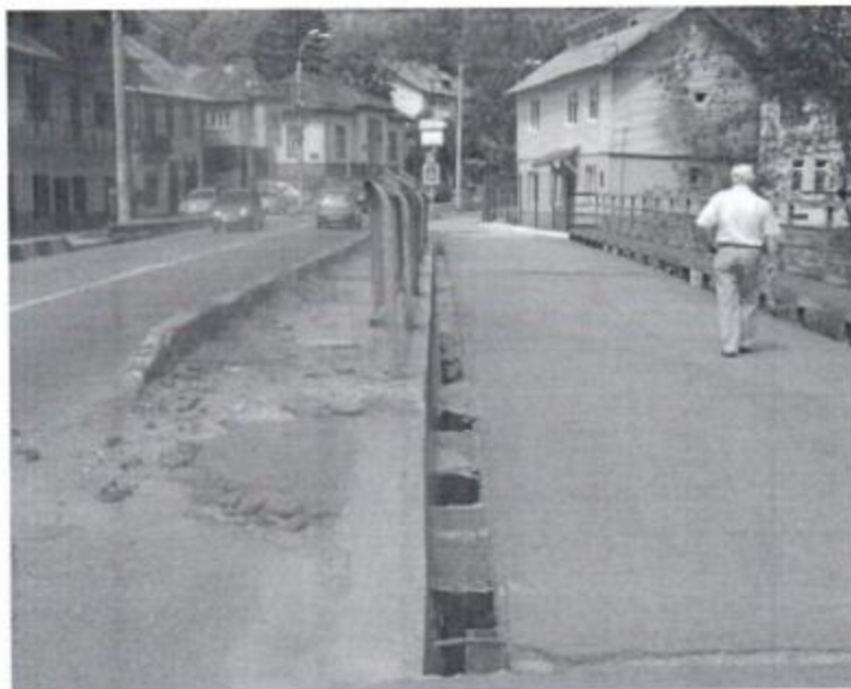
Vedere spre Brasov, pod rutier stanga si pod metalic provizoriu dreapta
