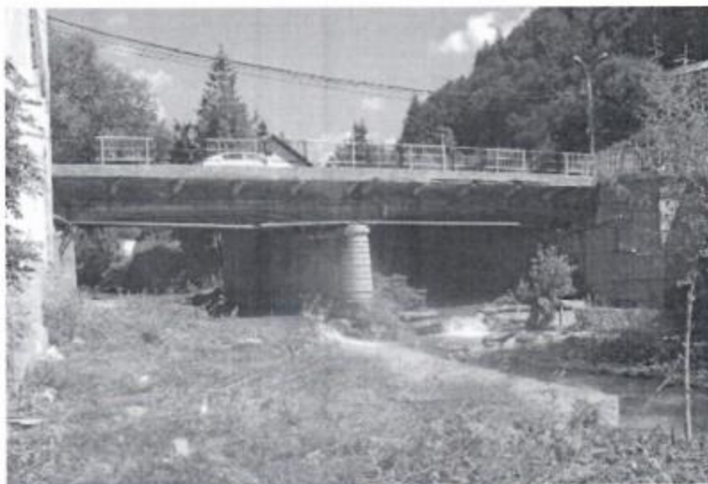
Vedere elevatie aval pod rutier
