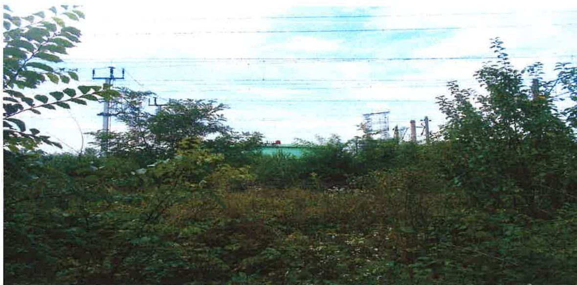
Foto 8 – vedere pe traseu înainte de traversare CF București - Ploiești înspre rafinăria Petrobrazi
