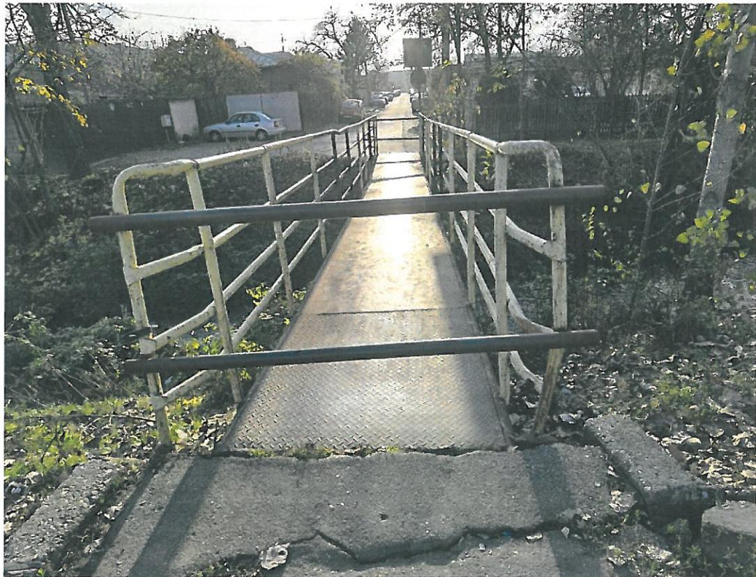
Suprastructura pasarelei este alcătuită în secțiune transversală din 2 grinzi metalice (teava  $\Phi 110\text{mm}$ ) cu lungimea de 13,10m. Pe deschiderea centrală de 8,20m cele 2 tevi sunt dublate de alte tevi cu diametrul  $\Phi 110\text{mm}$  ce se continuă cu stalpii inclinați ai cadrului. Grinzelile sunt solidarizate în sens transversal prin intermediul unor antretoaze din tevi cu diametrul  $\Phi 110\text{mm}$ .
