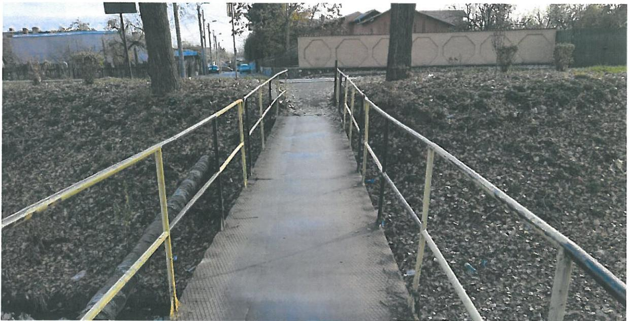
Suprastructura pasarelei este alcatuita in sectiune transversala din 2 grinzi metalice (profile I24) cu lungimea de 16,75m, dispuse la distanta interax de 1,40m. Grinzile sunt solidarizate in sens transversal prin intermediul a 8 antretoaze din profile U10, avand latura mare orizontala si laturile mici rezemate pe talpa inferioara a grinzilor principale.
