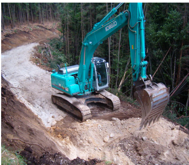
Fig. 6. Excavator în funcționare normală
