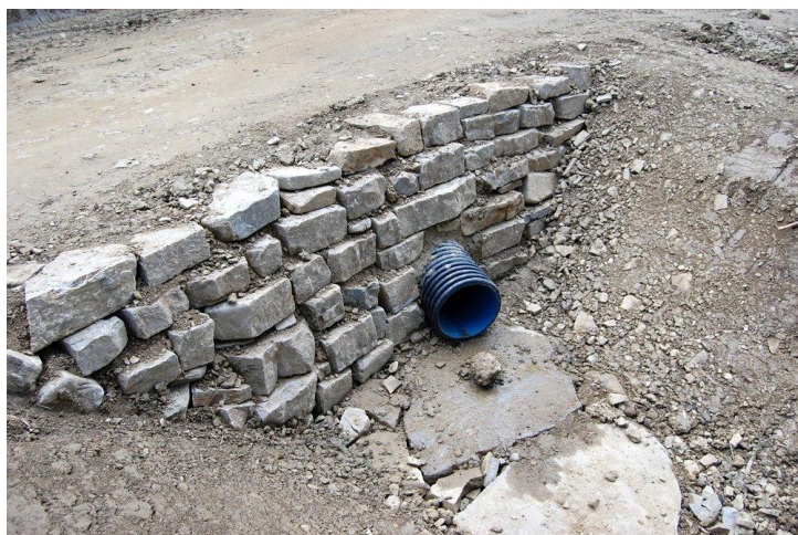
Fig. 10. Radier amonte podeț tubular
