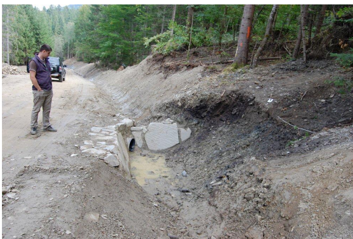
Fig. 8. Racordare amonte podeț tubular descărcare șanț
