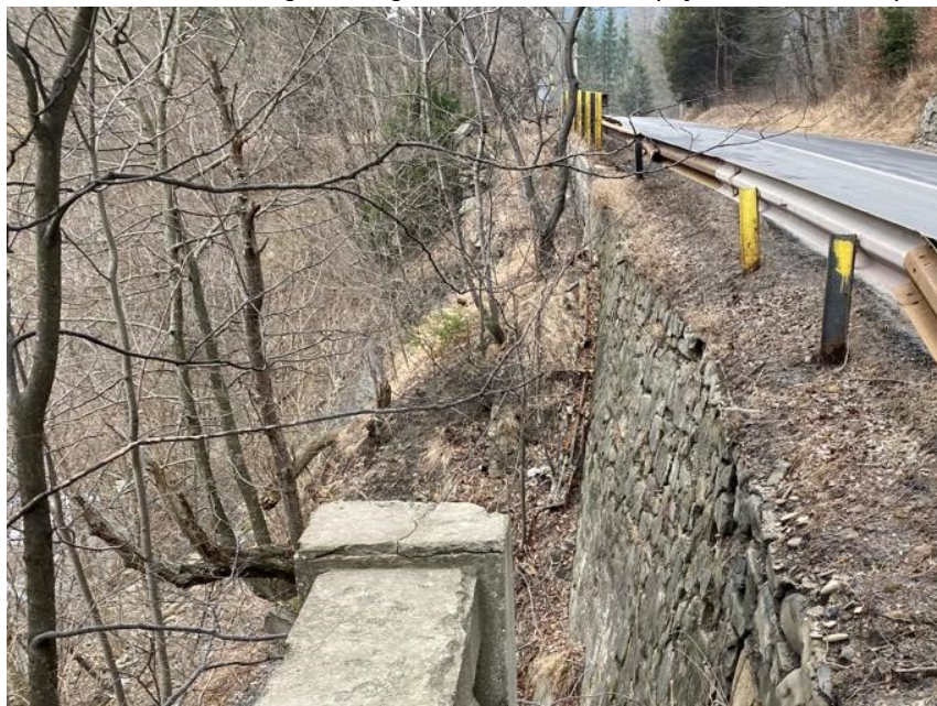
Imagine fotografica nr.3 – Zid de sprijin din zidărie de piatra, cu fundare directa
