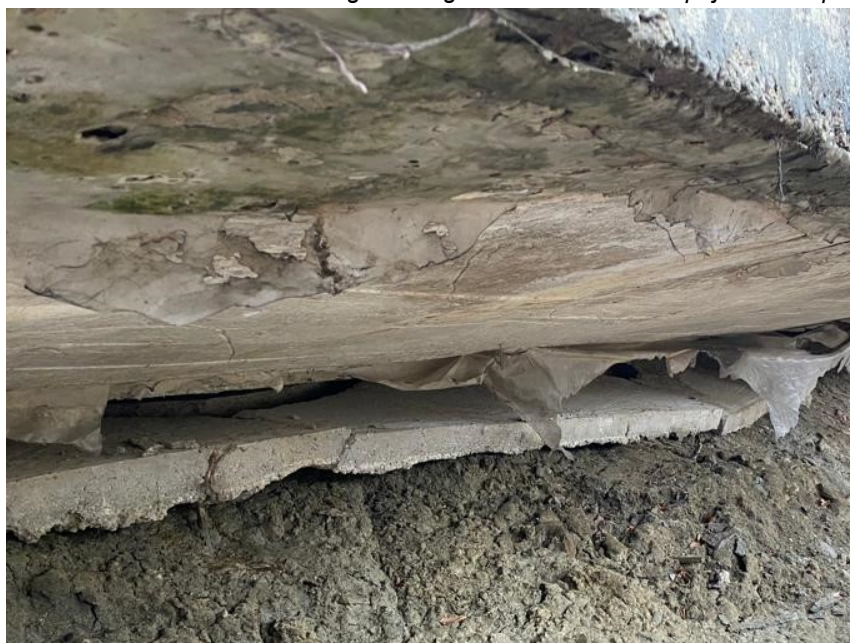
Imagine fotografica nr.2 – Zid de sprijin fundat pe piloti din beton armat
