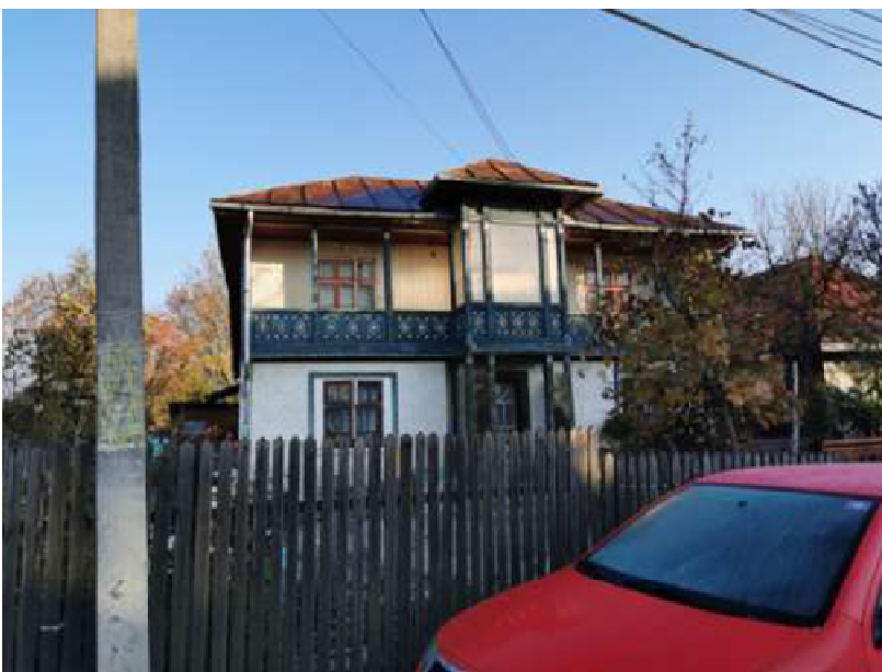
Casă P+1, tradițională, cu parapet din lemn decorat, nr. 121, Podu Lung
