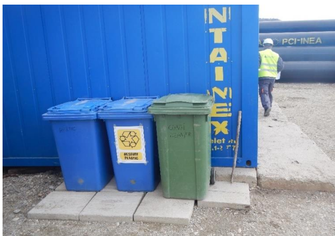
Punct gospodăresc cu pubele pentru colectarea raționată a deșeurilor
