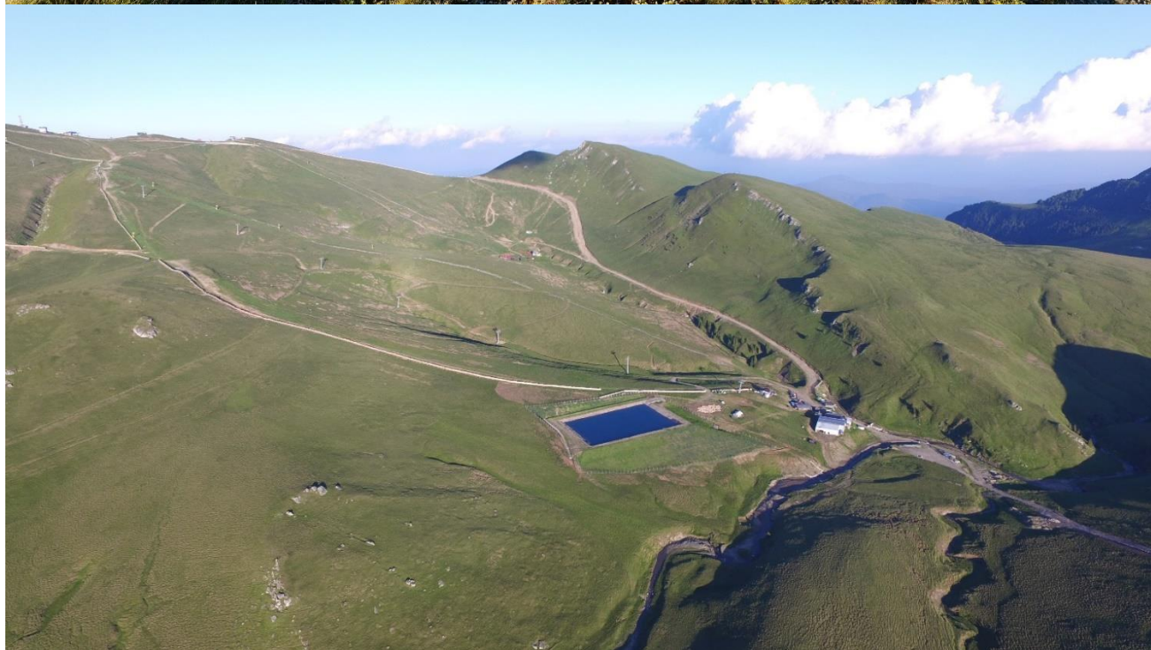
Figura 49. Aspecte de la nivelul Domeniului Schiabil Sinaia
