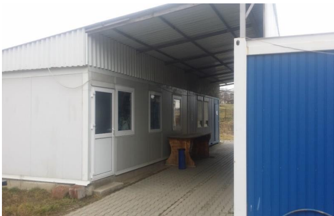
Soluție de amenajare containere modulare
