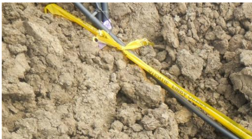
Figura 12. Model de pozare a unui cablu electric însoțit de panglica de avertizare
