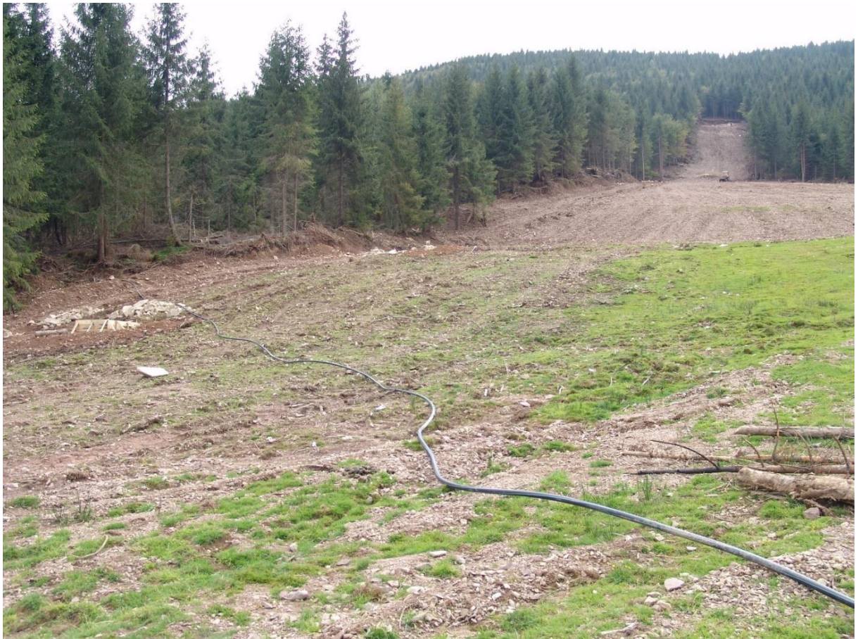
Figura 37. Aspect al impactului generat de construirea unei pârtii de schi. Se observă intervențiile agresive la nivelul arboretelor proximale, ablația stratelor de sol vegetal, îndepărtarea micrahabitadelor
