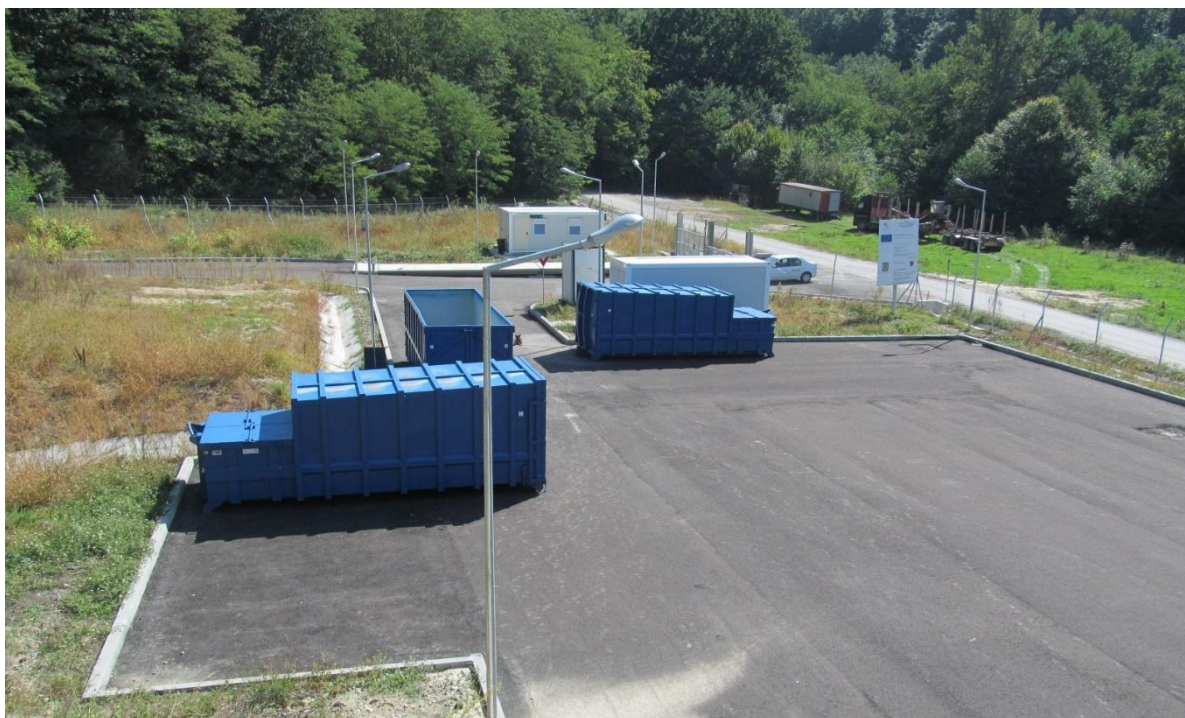
Fig.VII.1.7. Stația de transfer deșeuri din Sănmihaiu Almașului
