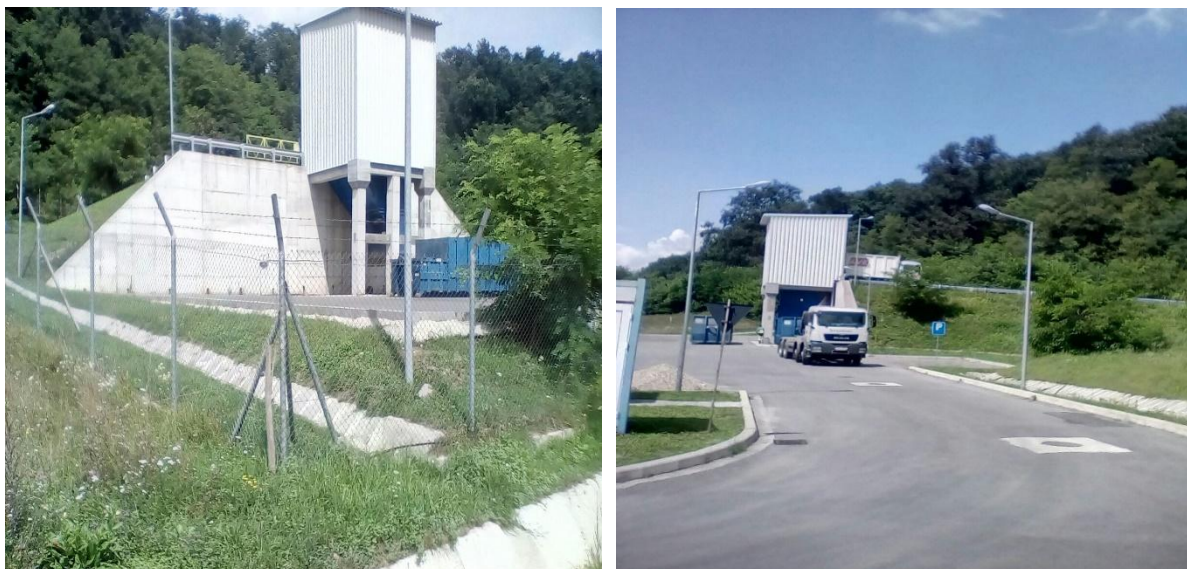
Fig.VII.1.6. Stația de transfer deșeuri din Surduc
