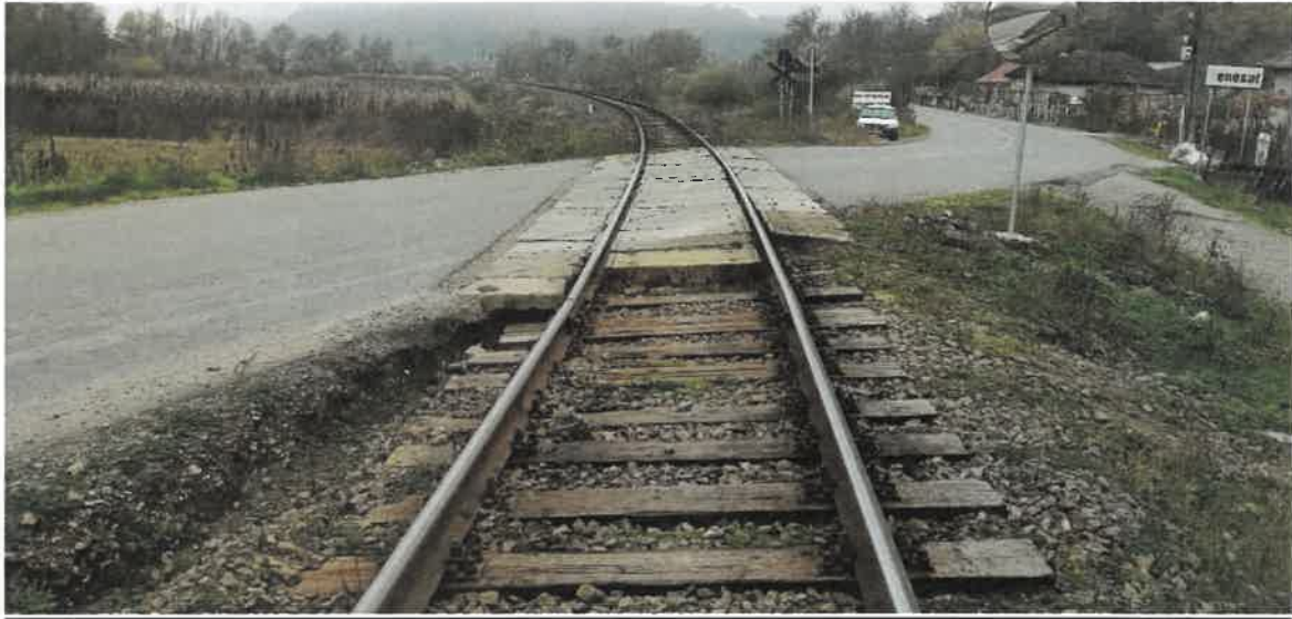
Foto – Amplasamnetul proiectului – Trecere la nivel si terasament cale ferata
