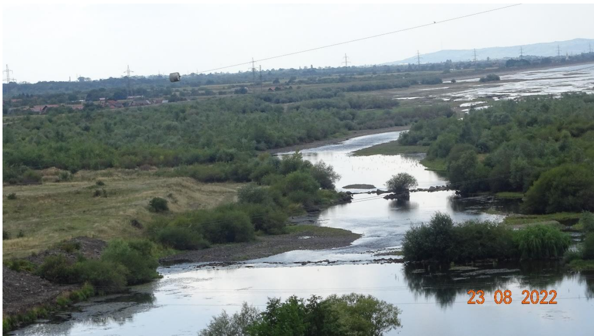
Figura nr. 17 Aspect amplasament km 64 zona de traversare a râului în ROSPA0123 și ROSAC0050
