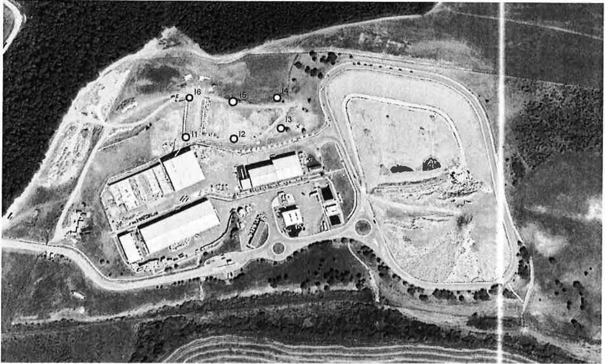
Fig. 2. Amplasare foraje I1 ÷ I6 (sursa foto: Google Maps)
