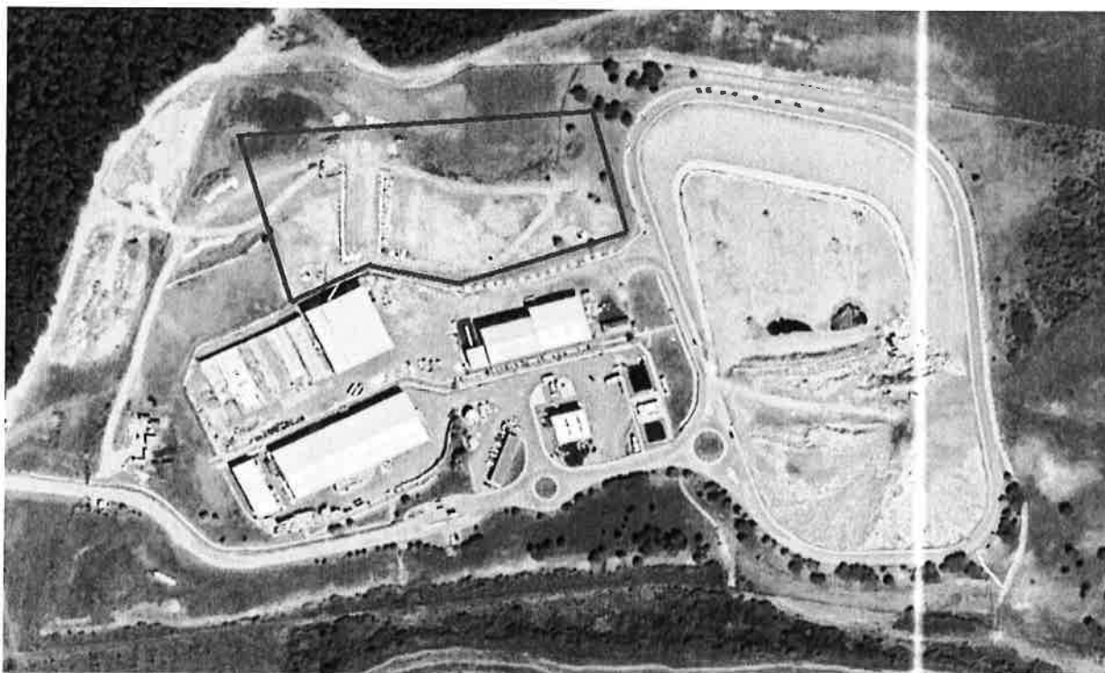
Fig. 1. Arealul monitorizat (sursa foto: Google Maps)
