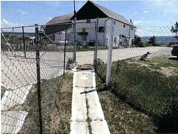
Accesul în sediul administrativ și filtrul sanitar
