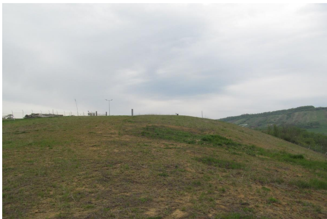
Fig.VII.1.10. Depozitul de deșeuri municipale din Cehu Silvaniei după închidere
