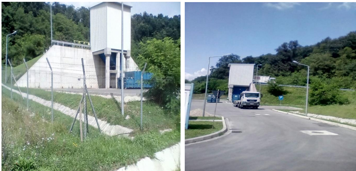
Fig.VII.1.6. Stația de transfer deșeuri din Surduc
