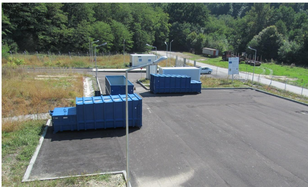
Fig.VII.1.7. Stația de transfer deșeuri din Sânmihaiu Almașului
