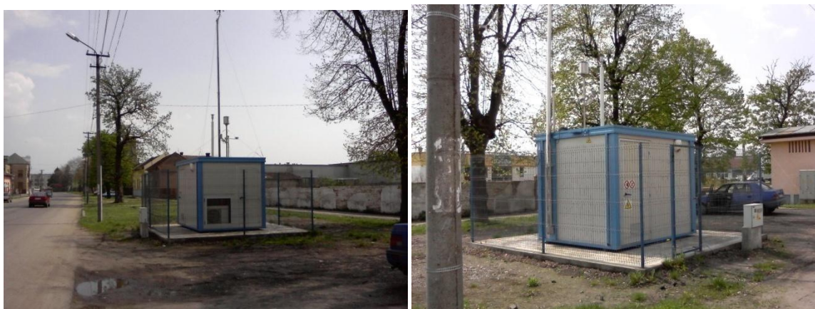
Figura 2.2.2. Stația de automată de monitorizare a calității aerului SM2
