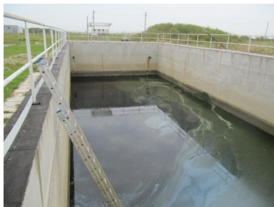
Figură VII.1.1.8 Depozitul Regional Doba – bazinul colectare levigat
