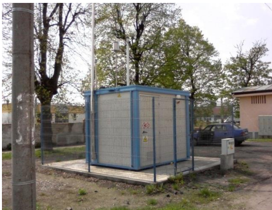
Figura I.1.1.2. Stația de automată de monitorizare a calității aerului SM2
