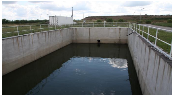
Figură VII.1.1.8 Depozitul Regional Doba – bazinul colectare levigat
