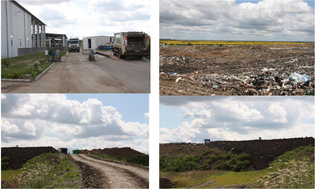
Figura VII.1.1.4 Depozitul ecologic Doba
