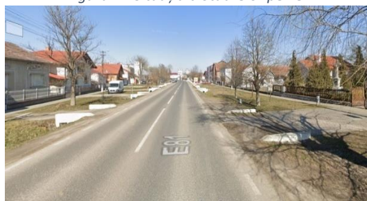
Figura 12 Situația trotuarelor pe E81
