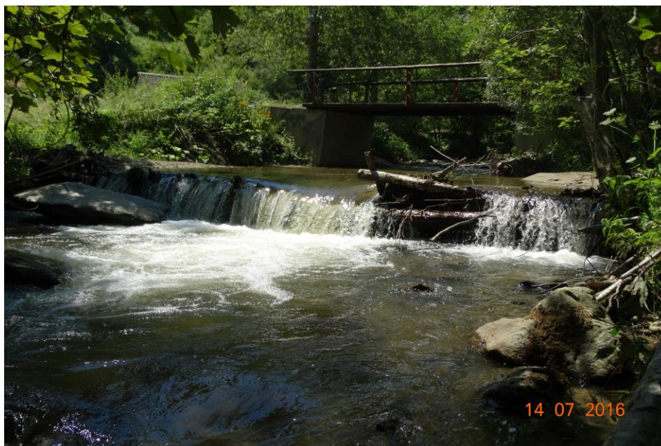
Fig. 3.1.3 Baraj de lemn pe râul de pe Lotrioara în zona de implementare a proiectului.
