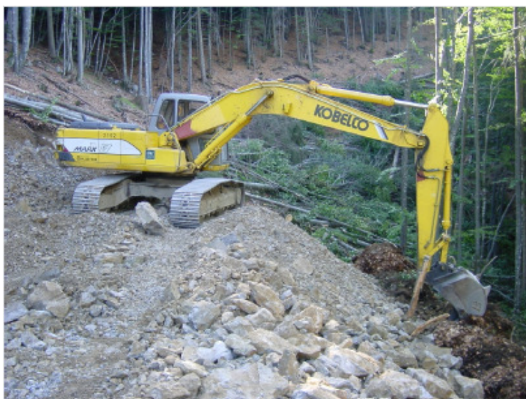
Excavator în lucru, cf. Ghidului de bune practici pentru drumuri forestiere
