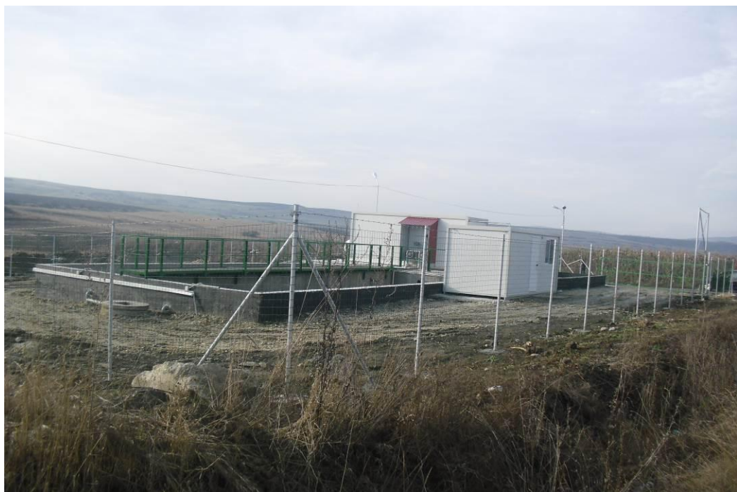
Fig. 5 - Stația de epurare din satul Ruși
