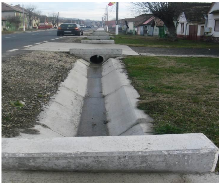
Fig. 4 – Rigole pentru scurgerea apelor pluviale în localitatea Ruși pe DN14
