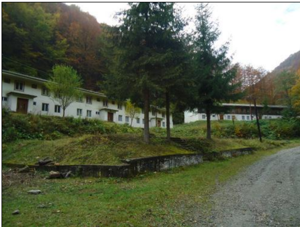
Figura nr. 137 – Aspect privind existența a două construcții cu funcție de cazare situate în perimetrul trupului nr. 7 (zonă de agrement pe Valea Căprăreț)
