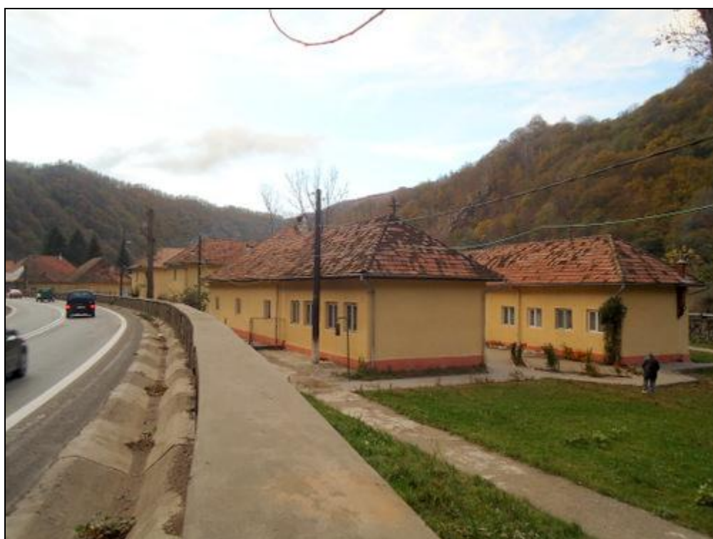
Figura nr. 39 – Aspect privind construcțiile existente în cadrul trupului nr. 2 (sat Lazaret) – clădiri aparținând Centrului de recuperare și reabilitare neuropsihiatrică Raul Vadului
