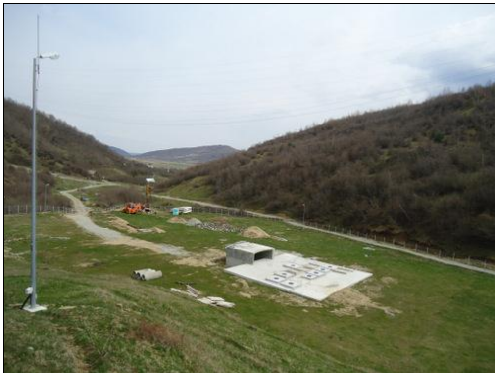
Figura nr. 34 – Aspect privind execuția lucrărilor aferente captării și tratării apei potabile destinate localității Boița
