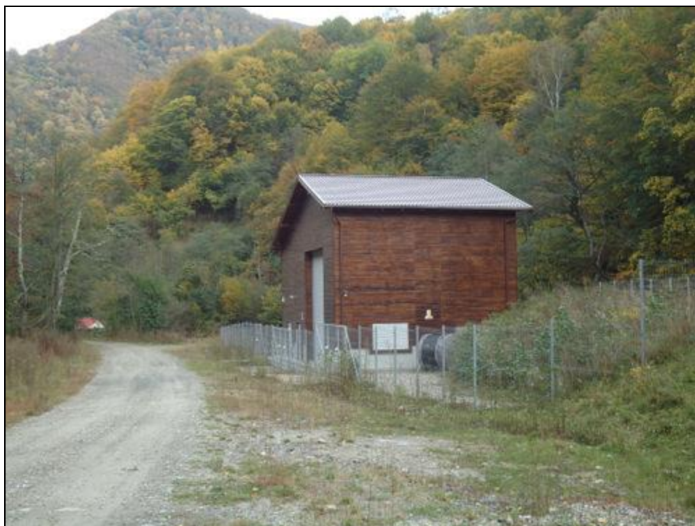
Figura nr. 164 – Aspect privind prezența clădirii microhidrocentralei de pe Valea Căprăreț în perimetrul trupului nr. 12
