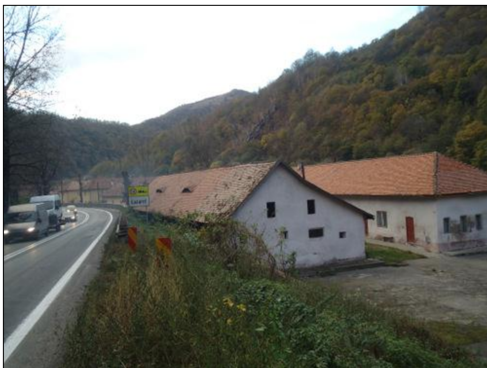
Figura nr. 38 – Aspect privind construcțiile existente în cadrul trupului nr. 2 (sat Lazaret) – clădiri aparținând Centrului de recuperare și reabilitare neuropsihiatrică Raul Vadului
