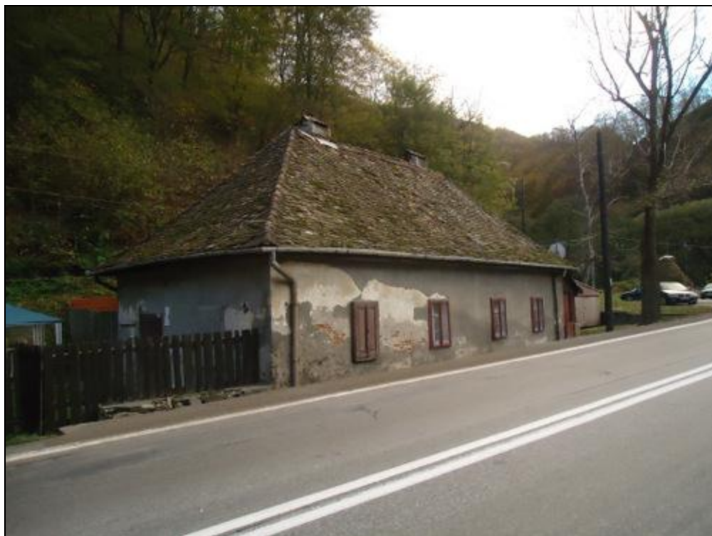
Figura nr. 40 – Aspect privind construcțiile existente în cadrul trupului nr. 2 (sat Lazaret) – clădire situată pe parte opusă a DN 7 față de Centrul de recuperare și reabilitare neuropsihiatrică Raul Vadului
