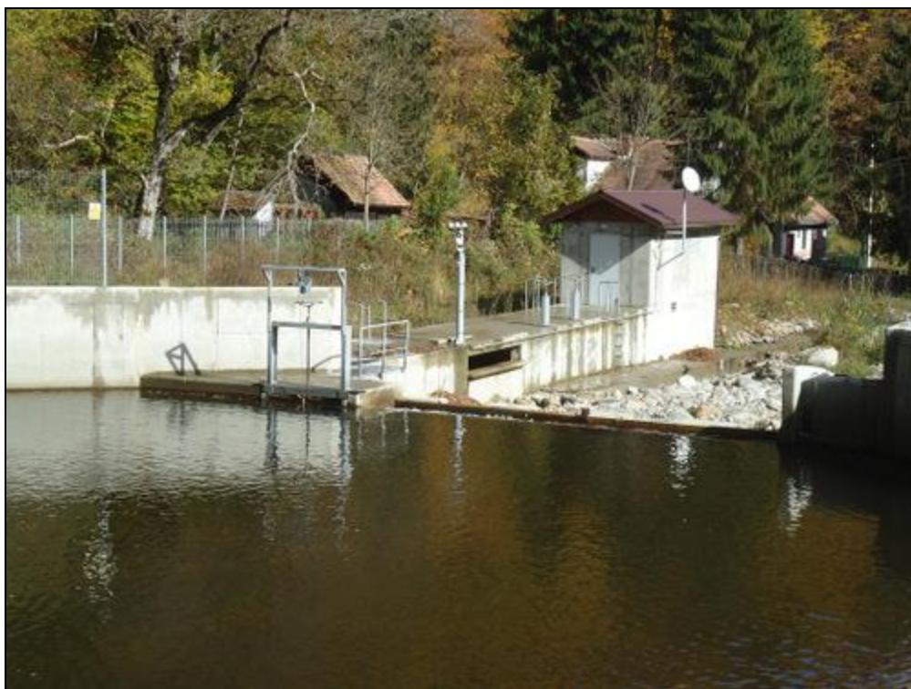
Figura nr. 150 – Aspect privind zona de captare a microhidrocentralei existente pe Valea Căprăreț (Vad), situată în perimetrul trupului nr. 10
