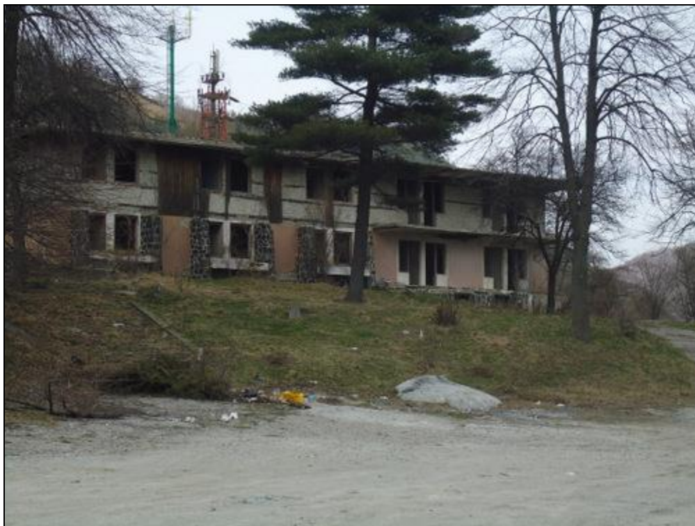
Figura nr. 65 – Aspect privind prezența unei construcții abandonate, fost structură de cazare, în perimetrul trupului nr. 6
