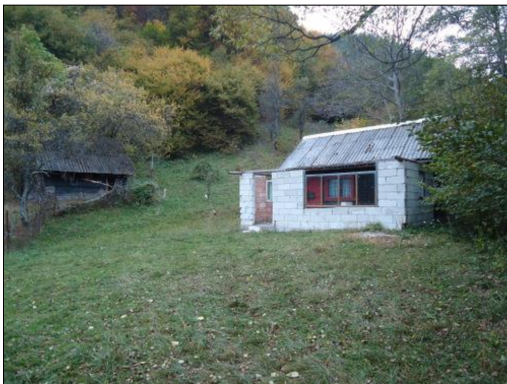
Figura nr. 172 – Aspect privind prezența unei colibe/case de vacanță aflate în extindere în perimetrul trupului nr. 25 (zonă de agrement)
