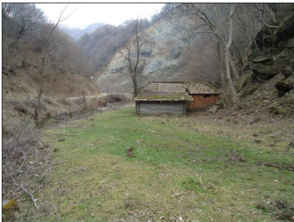
Figura nr. 186 – Aspect privind prezența unei case în stare avansată de degradare și a unei anexe aferente în perimetrul trupului nr. 29 (zonă de agrement pe Valea Megheș)
