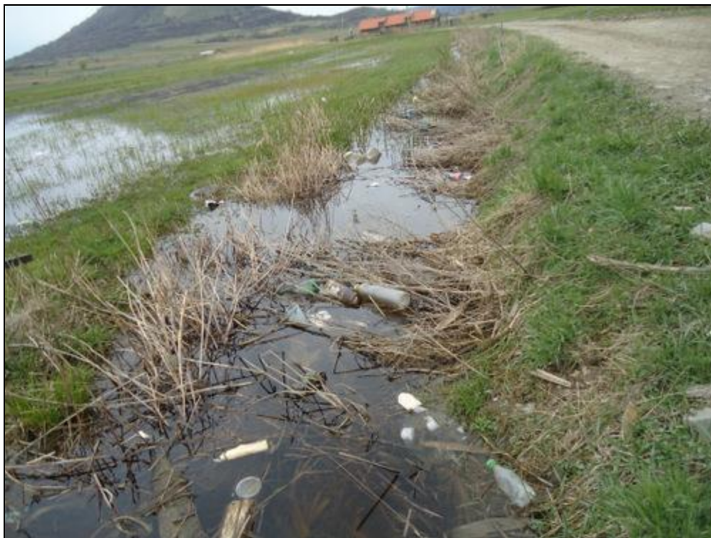
Figura nr. 20 – Aspect privind prezența unui șanț de dren în perimetrul extinderii estice a intravilanului localității Boița
