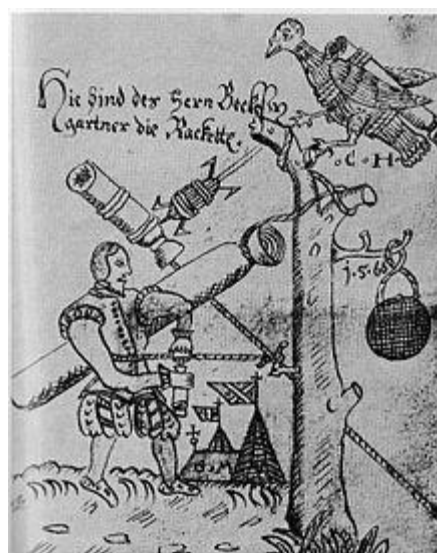
Conrad Haas (1529 – 1569), „Königlicher und Kaiserlicher Zeugmeister“ in Hermannstadt. Entwurf: „Wie du solt machen gar schöne Rackette, die da von im selber oben hinauff in die hoch faren“.
