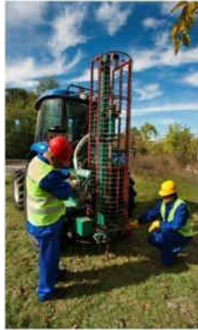
Fig. 7: Realizarea mecanică a găurilor
