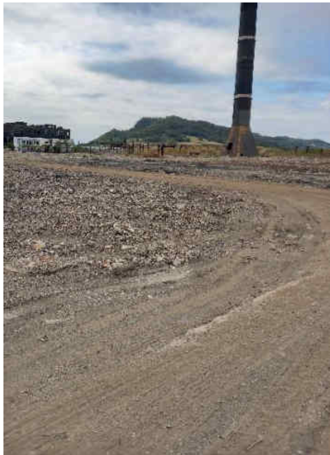
Fig.nr.3 Suprafata pentru instalare centrala fotovoltaica (100822)
