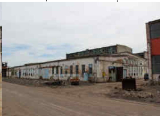
Stația electrică 21, clădire Stație compresoare
