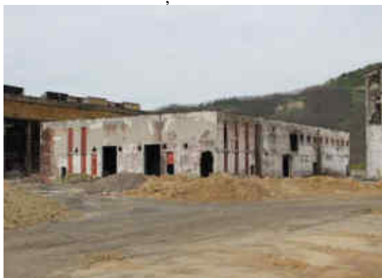
Stația electrică SRA
