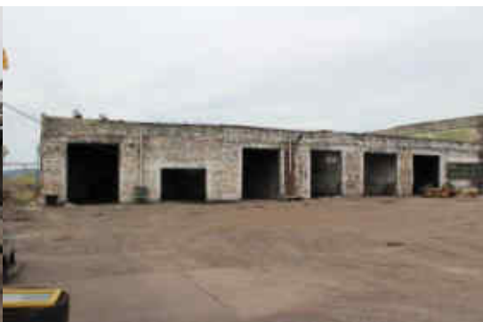
Garaje și atelier reparații auto
