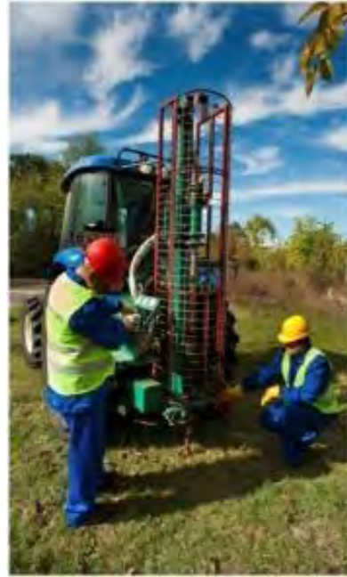
Fig. 7: Realizarea mecanică a găurilor
