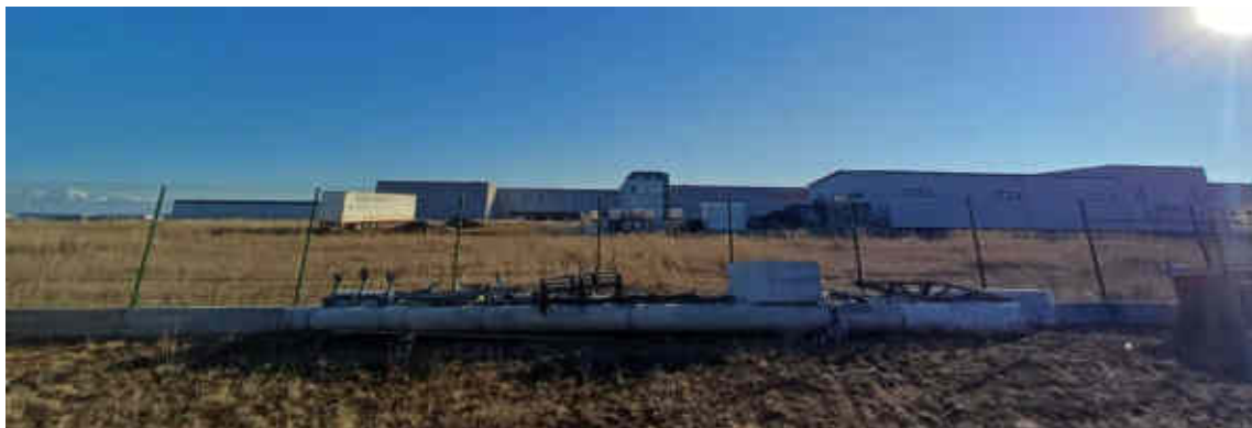
Fig. 5-4 Vedere din interiorul parcelei către S: teren agricol nelucrat, clădiri cu scop industrial-logistic
