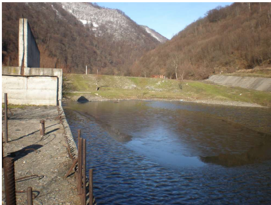
Foto 1 Pila despărțitoare poziționată pe mijlocul barajului devensor
