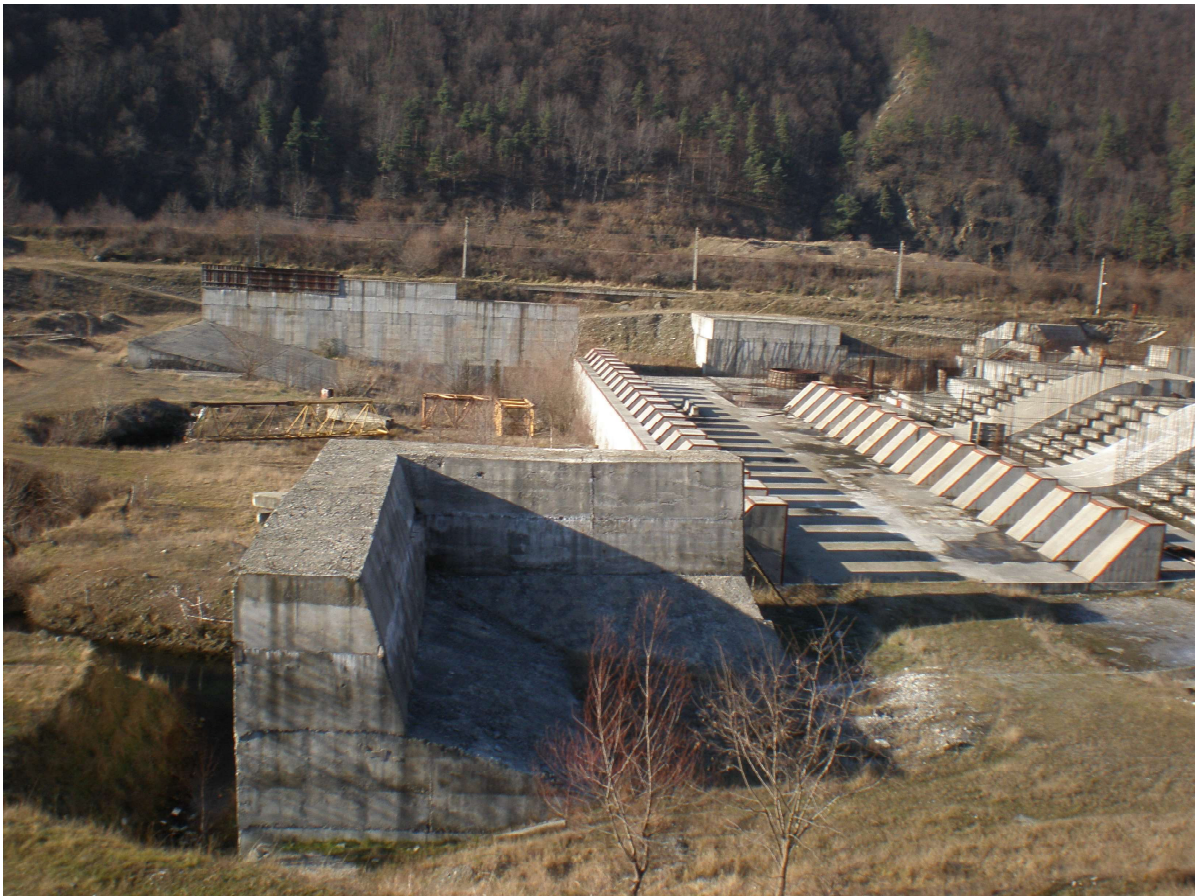
FOTO 1. Vedere de pe malul stâng asupra disipatorului de energie și a zonei de rizbermă
