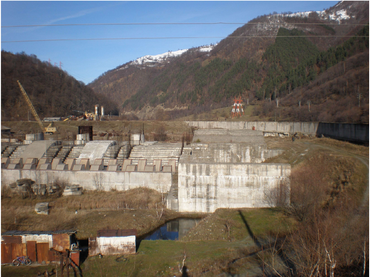
FOTO 2. Vedere din aval a barajului
