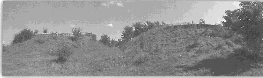
Foto nr. 1: Vedere ansamblu rezervoare ingropate
