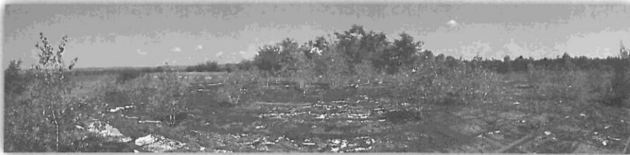
Foto nr. 2: Vedere ansamblu planseu rezervoare
