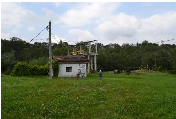
Figura 44: Amplasament existent – zona captare Avrig
