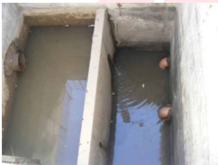
- decantor (separator) apa pluviala
