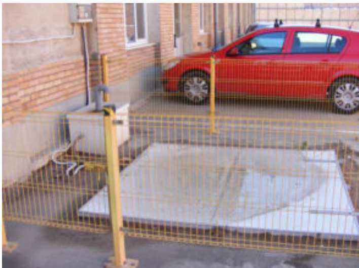
- statia de epurare
