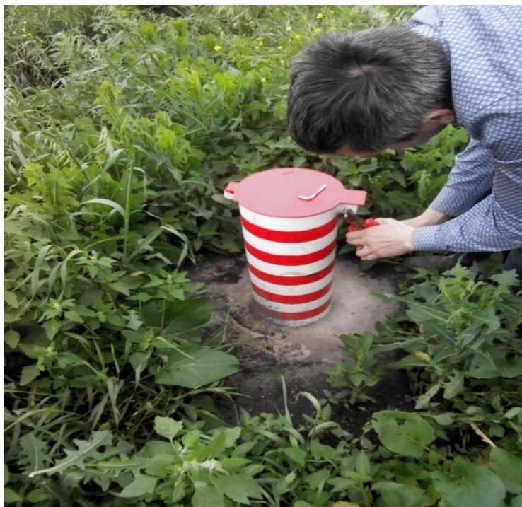
Figură 6. Imagine put monitorizare FP3 -aval
