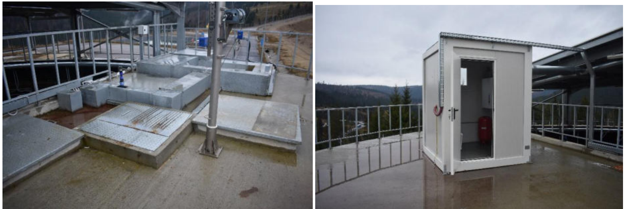
Figura 14 Bazinul tampon levigat și bazinele auxiliare
