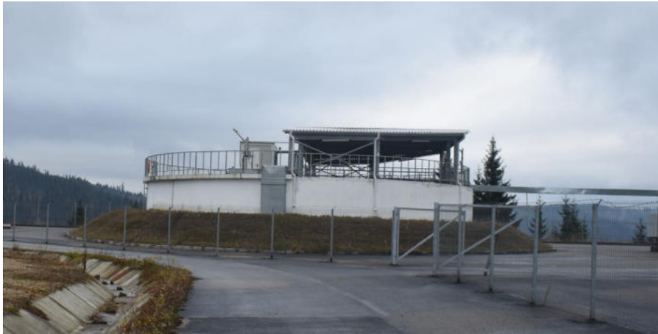
Figura 11 Bazinul tampon de levigat și bazinele auxiliare
