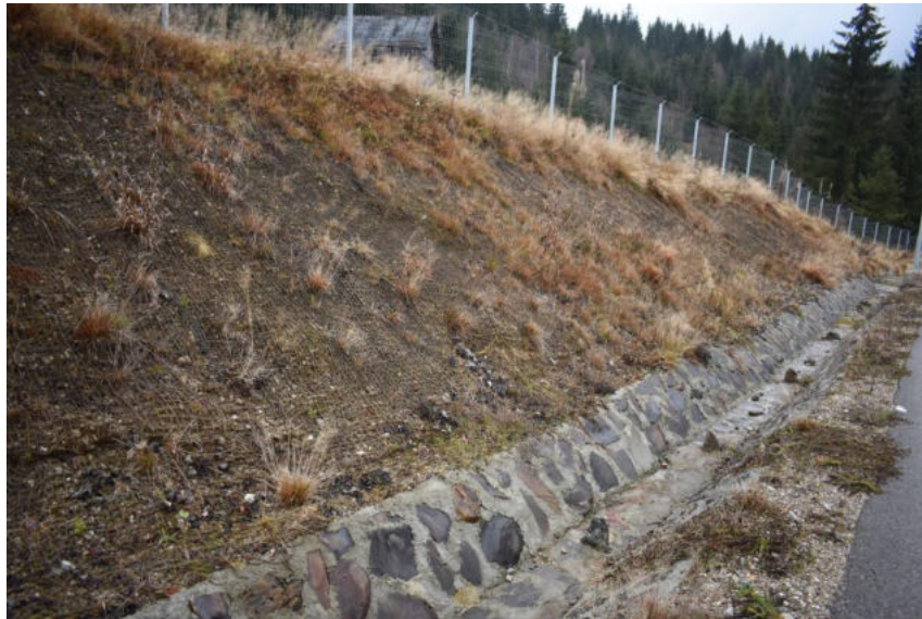
Figura 10 Rigola perimetrala sud-vest colectare ape pluviale
