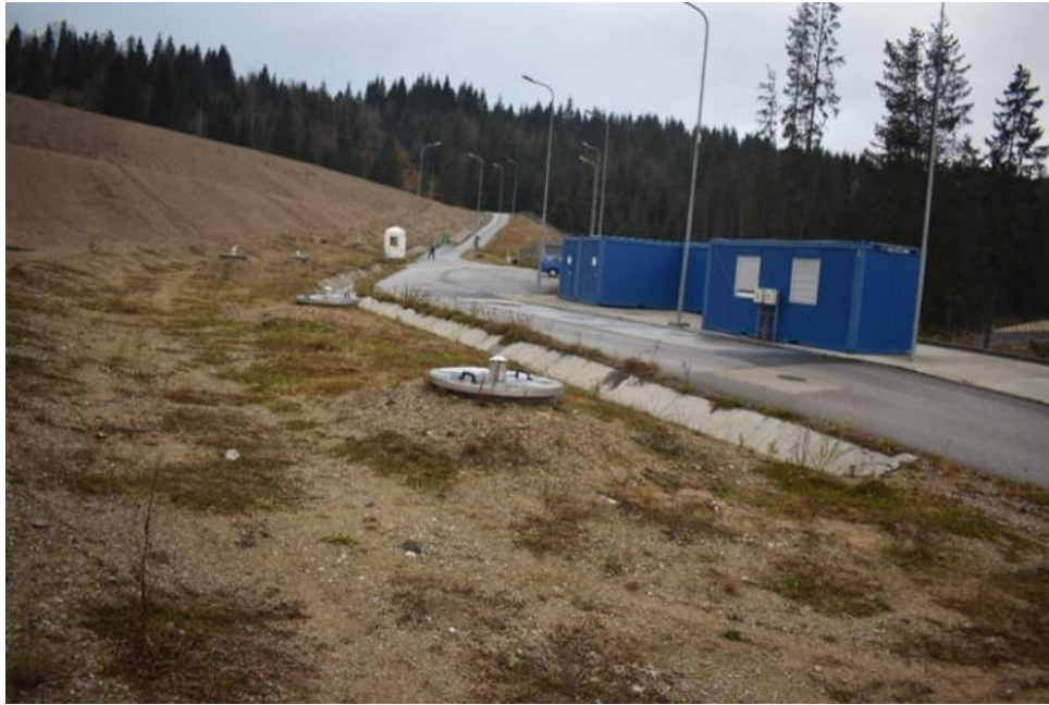
Figura 4 Camin de vizitare levigat
