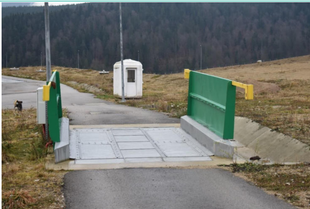
Figura 6 Instalația de spălare roți
