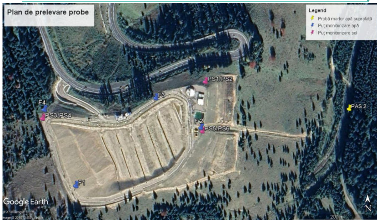
Figura 16 Locațiile puțurilor de monitorizare în cadrul depozitului Pojorata
