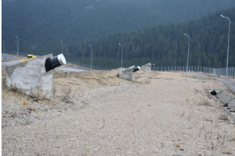
Figura 3 Capătul conductelor de drenaj al levigatului
